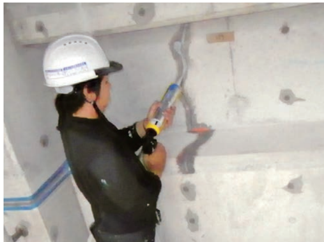
シーリング材による補修
