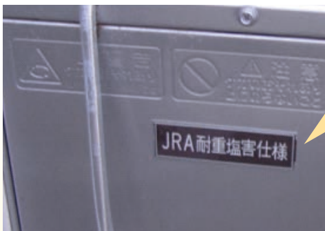
耐塩害仕様の室外機
