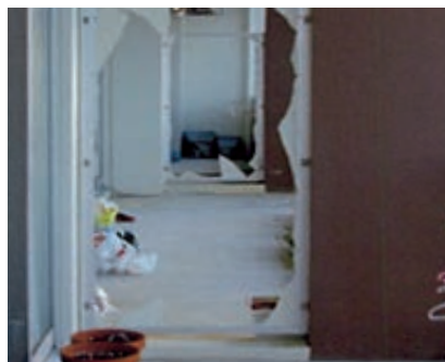
バルコニーの仕切り板 (共同住宅)
