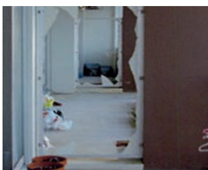
バルコニーの仕切り板 (共同住宅)
