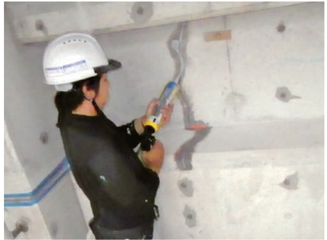
シーリング材による補修
