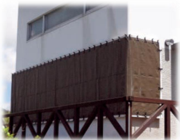
窓ガラスに設置されたハリケーン・ファブリックの様子
