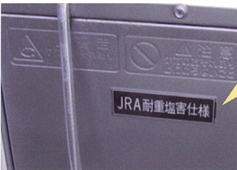
耐塩害仕様の室外機
